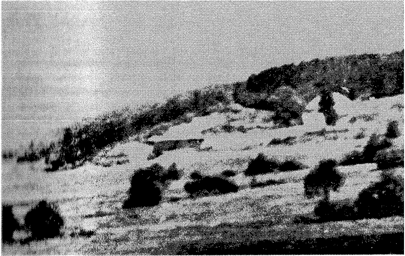
Blick von Amecke nach Norden auf die Julianenhütte mit Gieß- und Faktorenhaus. Der Kohlenschuppen ist zu dieser Zeit bereits abgerissen (weißer Fleck oberhalb der Hütte). Die Straße Amecke - Langscheid wird gerade über dem alten Obergraben aufgeschüttet. 1926
